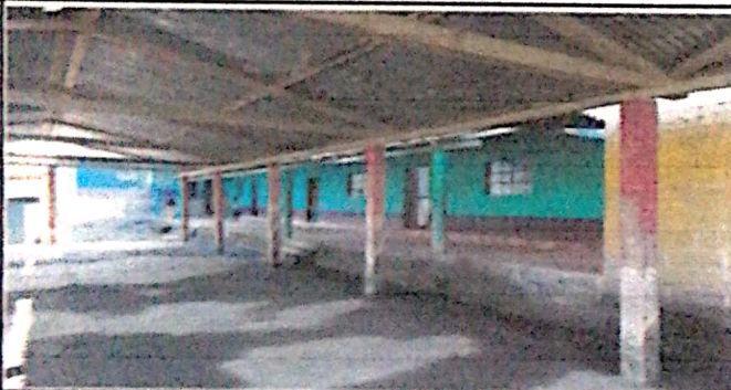
Foto 3: Cambio de techo y costaneras
