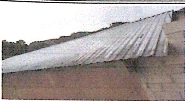
Foto 1: Cambio de techo
