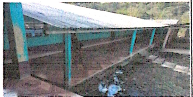
Foto 2: Colocacion de canales
